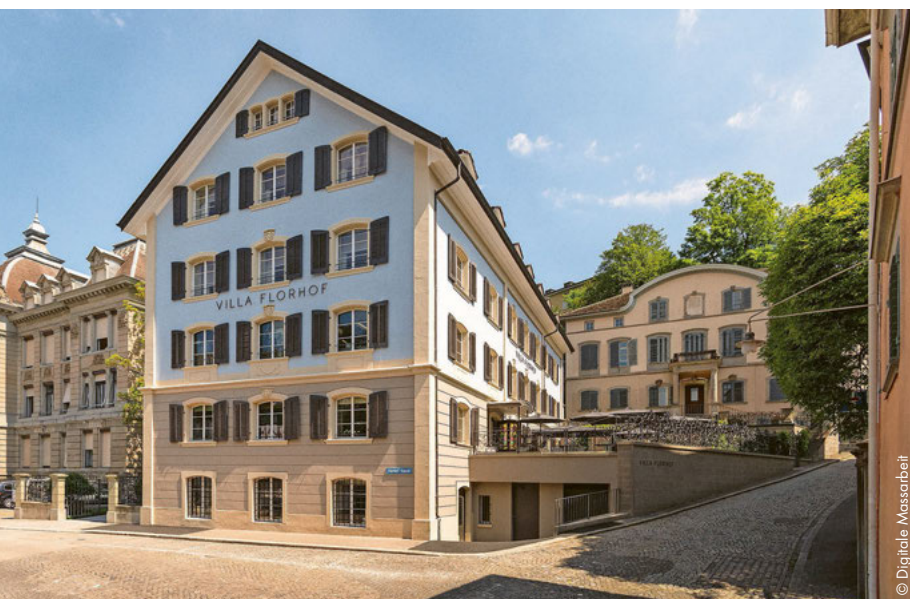
Die Villa Florhof nach der Renovierung
