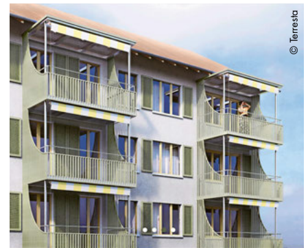
Die Wohnüberbauung Burgstrasse
