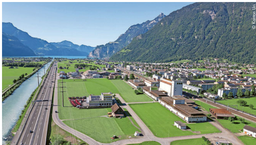
Das grösste Hochbauvorhaben auf der «Werkmatt Uri» ist in der Realisierung.
