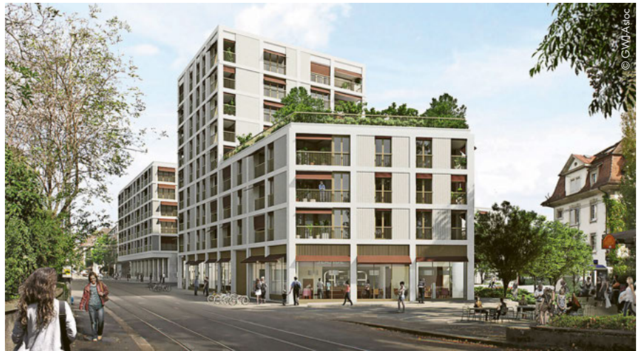
Das neue Quartierszentrum auf dem Meinen-Areal
