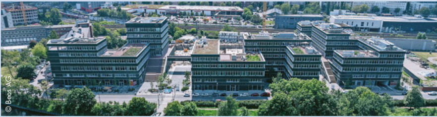
Der Innovationscampus Berlin Decks, Gebäude 1 &amp; 2 rechts im Bild
